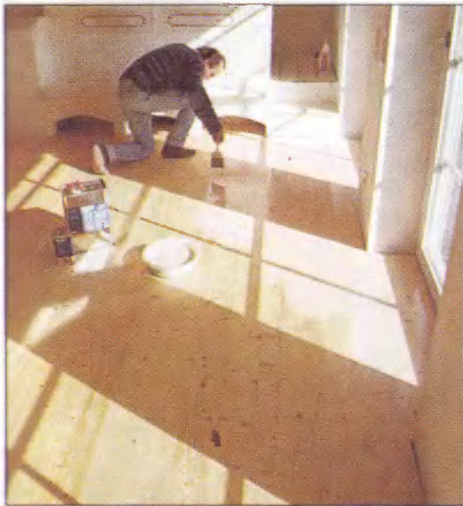
Пол настилаем от дальней стены, продвигаясь к выходу.
