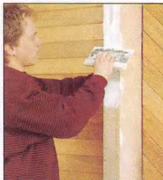
Торцы колонн должны быть абсолютно ровными. Их необходимо тщательно прошпаклевать.
