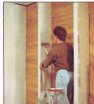
По просушенной обработанной шпаклевке клеим бумажные или стекловолоконные обои.
