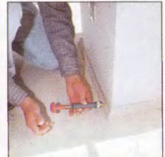
Окрашенный плинтус прибиваем гвоздями со шляпками подходящего цвета.
