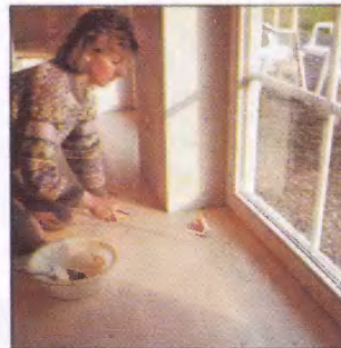
Второй слой лака можно наносить валиком. Разбавлять его уже не надо.
