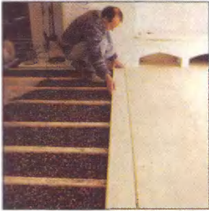
Пол настилаем от дальней стены, продвигаясь к выходу.
