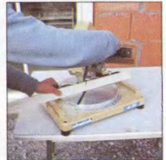
Профилированный плинтус в углах соединяем «на ус», опиливая его поперечной пилой.
