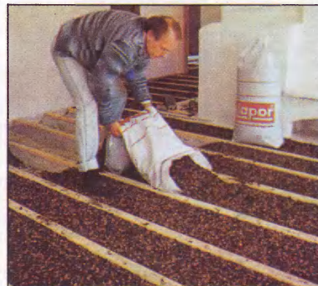
Для закрепления каркаса используем известковый раствор с керамзитом и песком.
