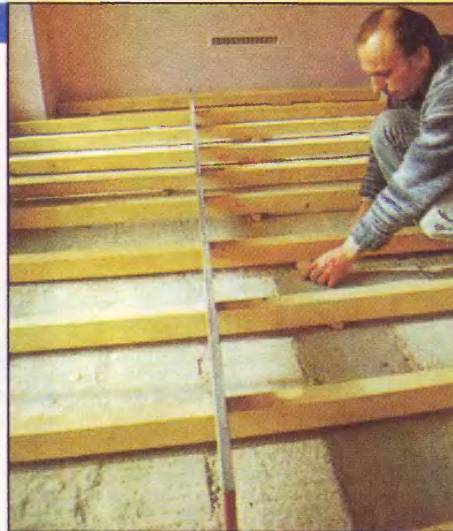
Для закрепления каркаса используем известковый раствор с керамзитом и песком.
