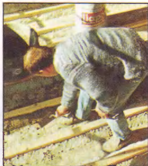
Делаем откосы для каждого бруска каркаса. Деревянные подкладки не вынимаем.
