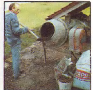
Для закрепления каркаса используем известковый раствор с керамзитом и песком.
