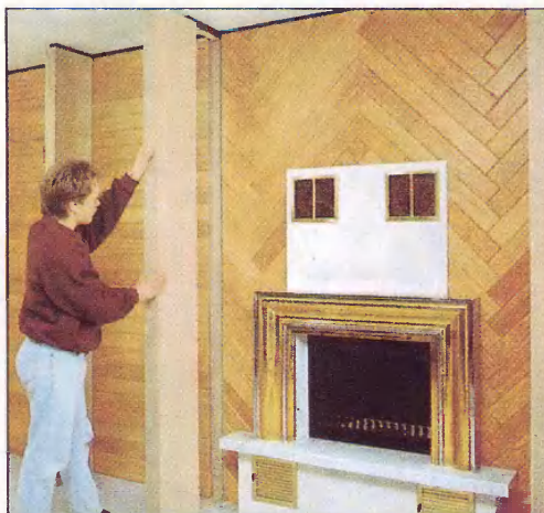
Коробчатые колонны крепим к опорам на полу и потолке.
