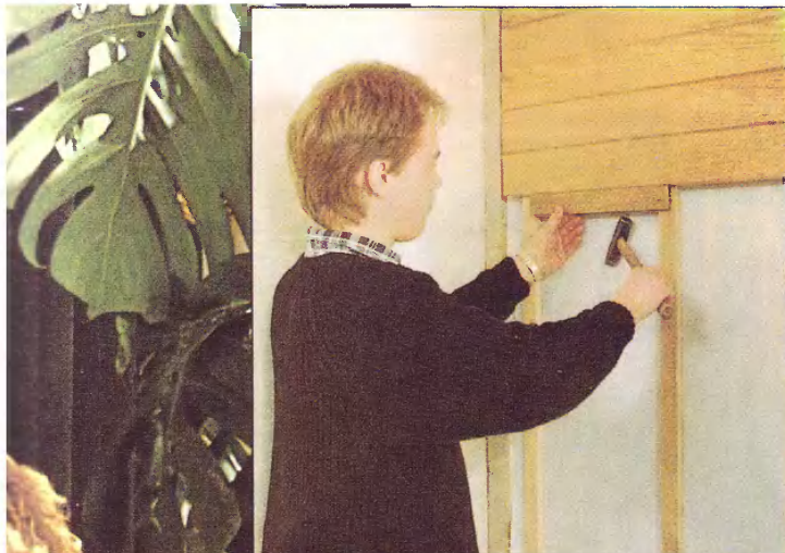
Промежуточная дощечка с гребнем предохранит пазы обшивки.
