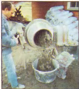
Замешиваем на воде до получения пластичного раствора 3 ч. песка, 3 ч. извести и 6 ч. наполнителя.
